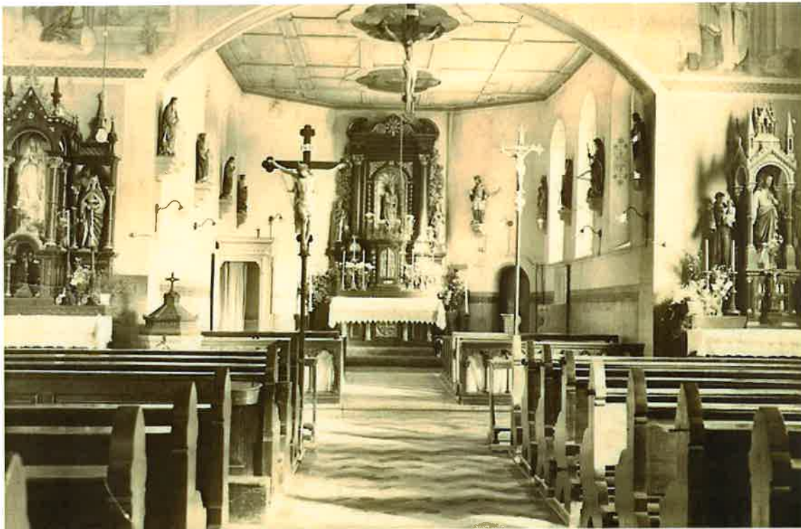
Innenraum der früheren Kirche von Unterstadion (vor der Renovierung). Der vordere Teil steht heute noch
