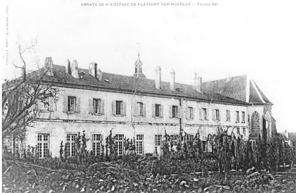
Die Ansicht von Osten
