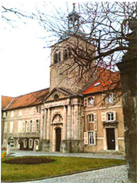
Flavigny-sur-Moselle - Portal und Eingang
